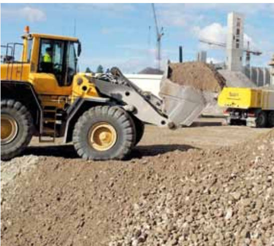
Betoroc BeM II -murskeen lastaus.
