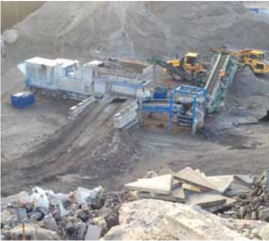
Betoroc-murskeen valmistus murskaamalla.
