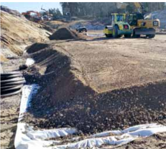
Betoroc-murskeella tehty rakenne.
