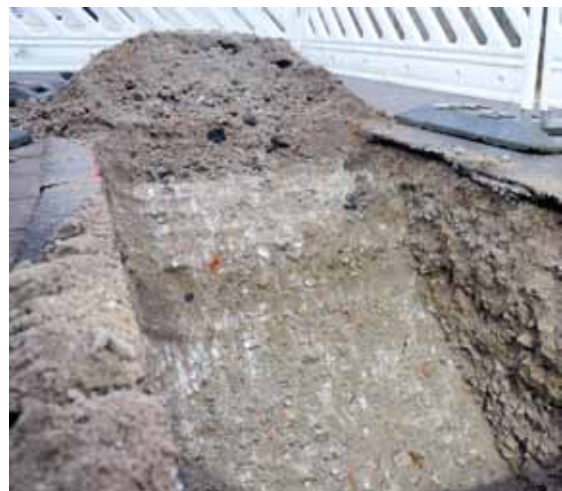
Aukikaivettu Betoroc-murskeella rakennettu katu-rakenne.
