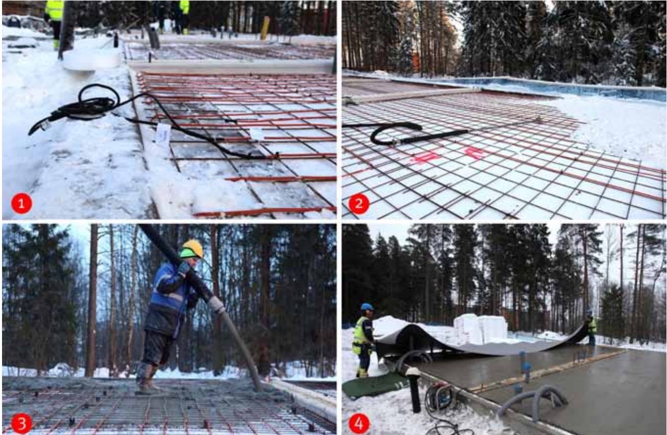
Kuva 7 Talvibetonoinnin vaiheet BET-lämmityskaapeilla 1: BET-lämmityskaapelin asennus 2: jään ja lumen sulatus 3: betonin valu, jonka jälkeen BET-lämmityskaapeleiden kytkeminen päälle 4: valun suojaaminen
