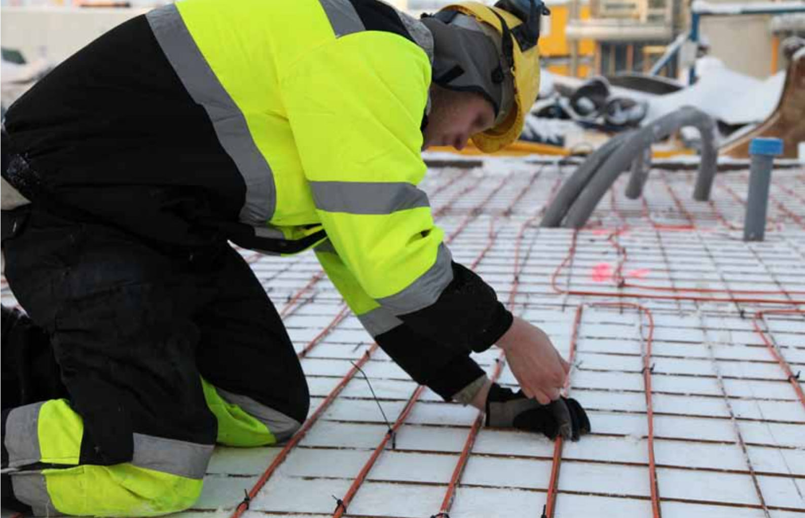
BET-lämmityskaapelin kiinnittäminen rauditusverkkoon nippusiteillä
