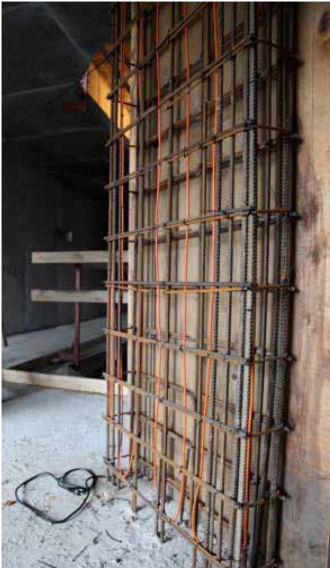
Kuva 18 Lämpölankojen sijainnit seinässä
