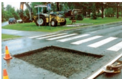
Pohja tasataan ja tiivistetään tarvittaessa.
