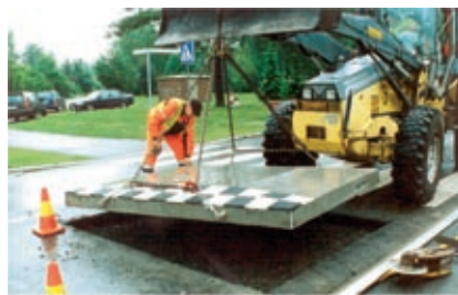
Tyynyhidaste-elementti nostetaan paikoilleen.
