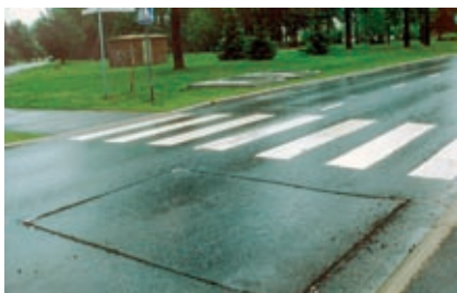
Asfalttiin leikataan 2800 x 2200 mm aukko.
