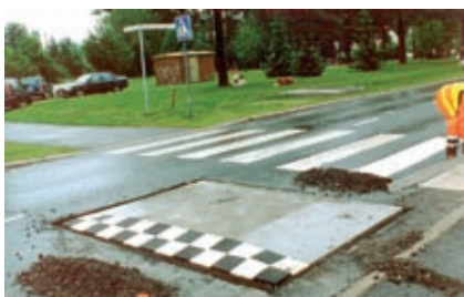
Rako täytetään asfalttimassalla.
