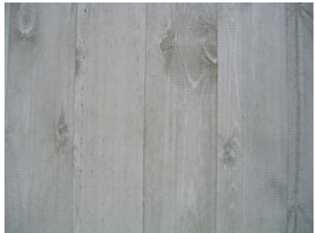
Itsetiivistyvällä betonilla valettua pintaa.
