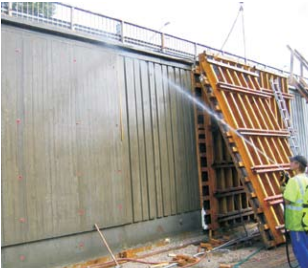
Jälkihoito kastelemalla ja suojaamalla.
