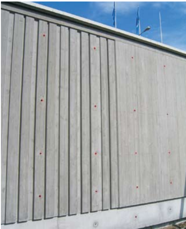
Itsetiivistävällä betonilla painevaluna tehtyä puhtasvalupintaa.
