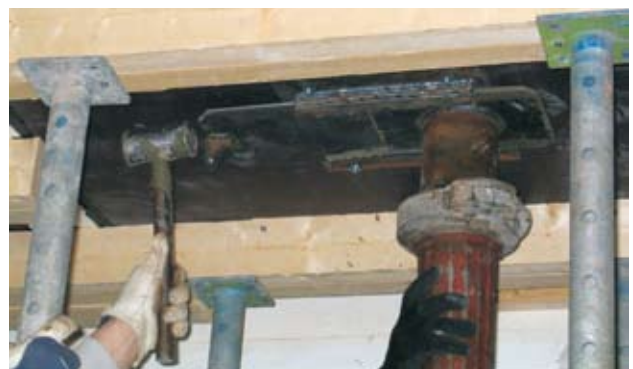
Painevaluna venttiin kautta toteutettu välipohjan vahvistusvalu.
