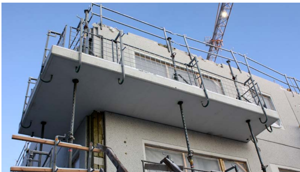
Kuva 32. Huolehditaan, että kylmät pinnat lämmitetään ennen saumausta.
