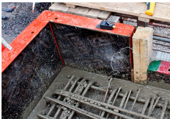
Kuva 10. Valun jälkeen seurataan betonin lämpötilaa.
