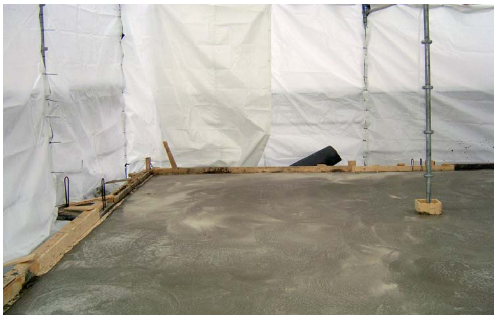
Kuva 18. Valut voidaan tehdä rauhassa lumipyryiltä sääsuojan alla.
