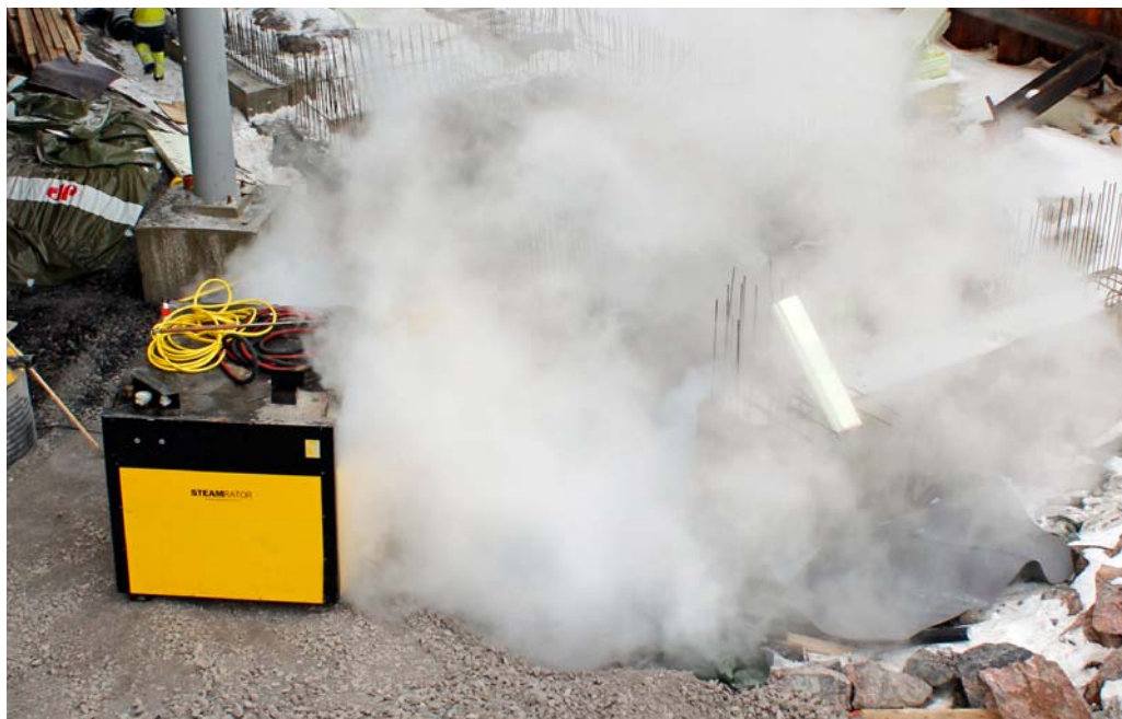
Kuva 11. Valualusta sulatetaan höyryn avulla ennen valua.
