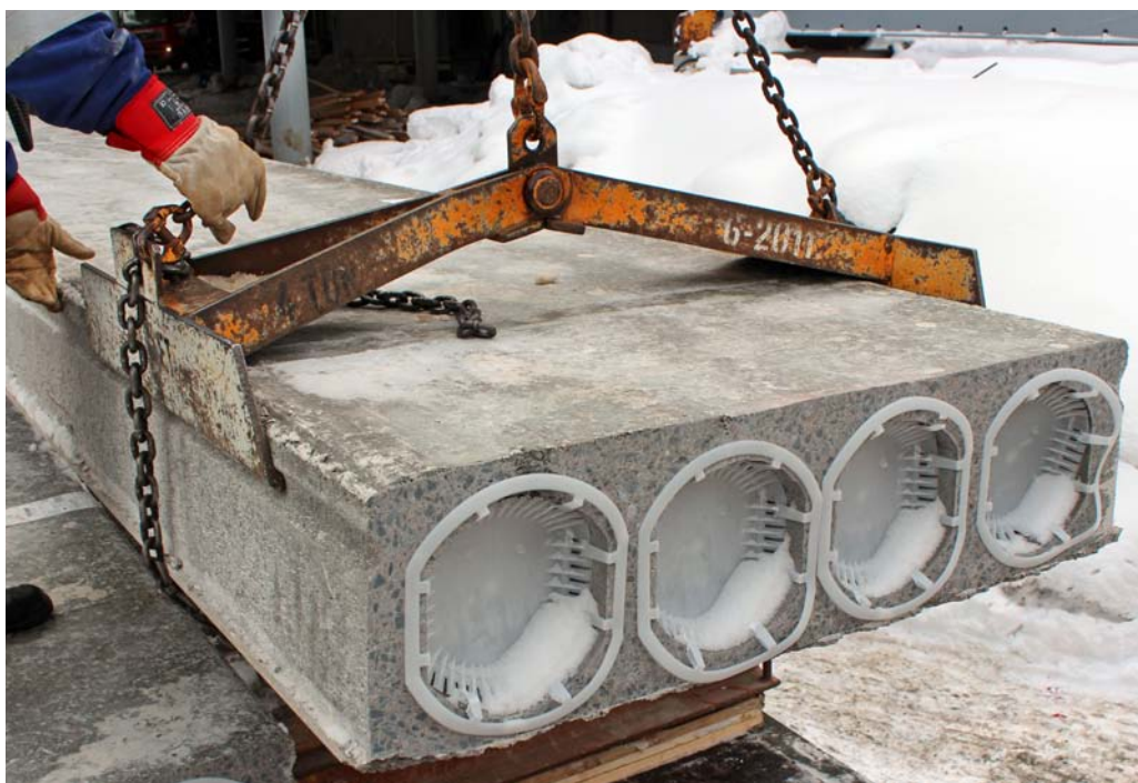
Kuva 29. Huolehditaan suojauksesta heti ontelolaattojen asennuksen jälkeen.
