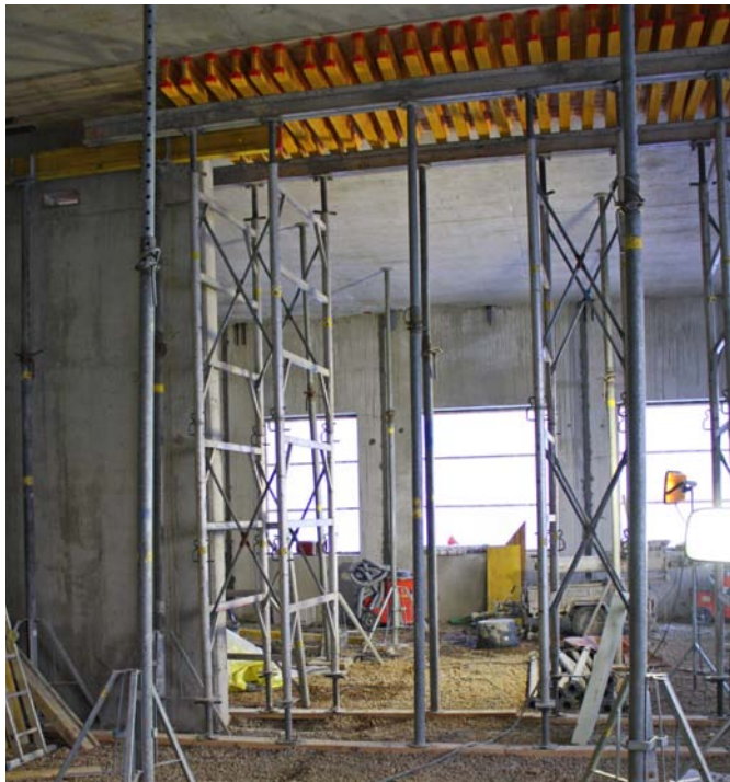
Kuva 7. Tukia ei saa purkaa, ennen kuin betoni on saavuttanut muotinpurkulujuuden.
