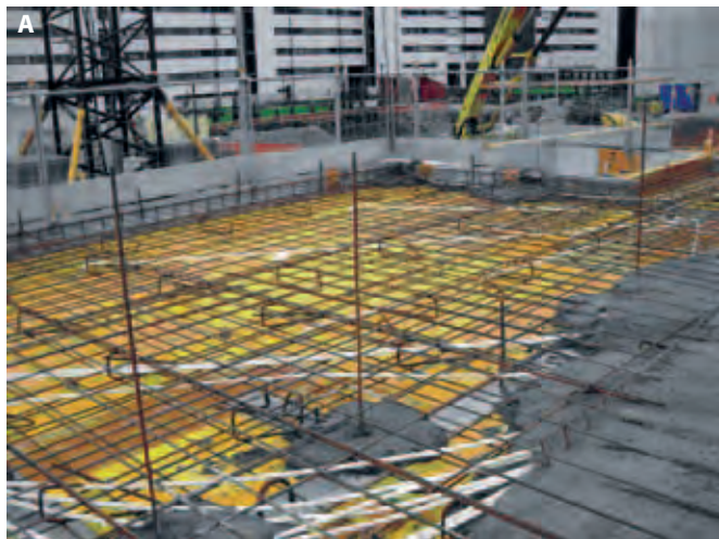
Kuva 18 a, b ja c. Erilaisia välipohjalaatan raudoitteita, irtotango, verkkorautoitteet ja mattorautoite.
