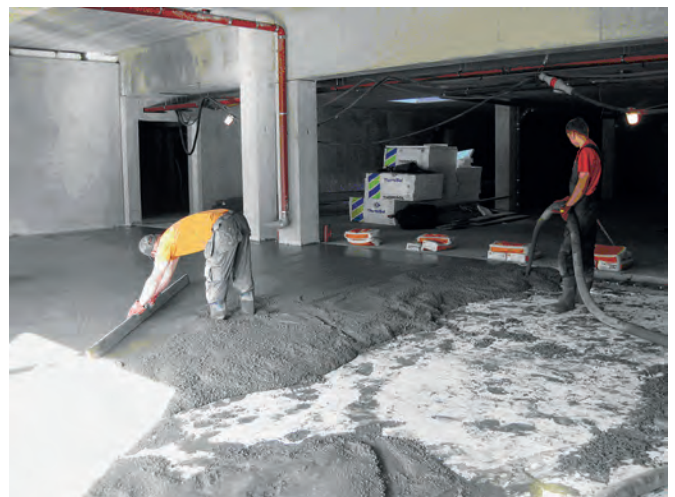
Kuva 2. Betonimassan levitys ja tiivistys
