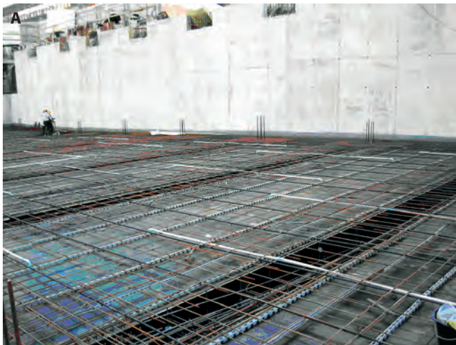
Kuva 24 a ja b. Jälkijännitetyn laatan raudoitteet
