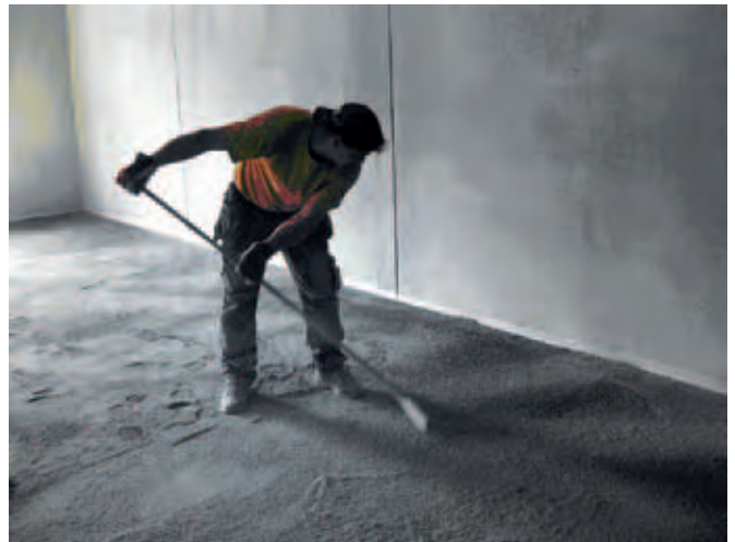
Kuva 7. Sirotteen levitystä
