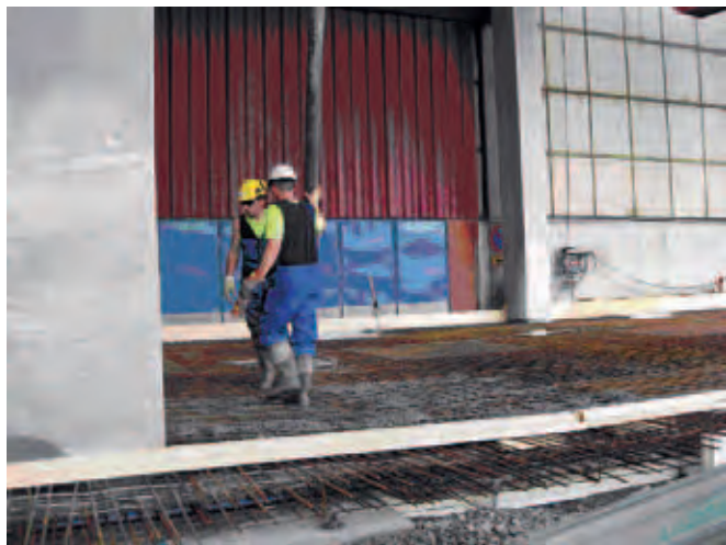
Kuva 14. Betonin siirto pumppaamalla
