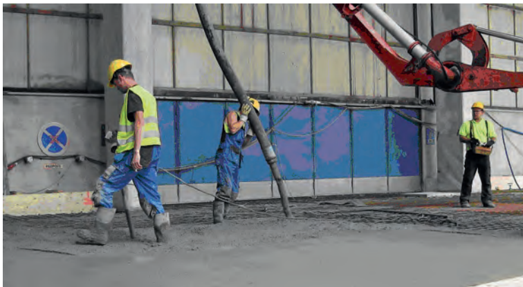
Kuva 10. Betonin siirto pumpulla
