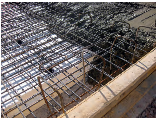
Kuva 1. Laatan raudoitteita
