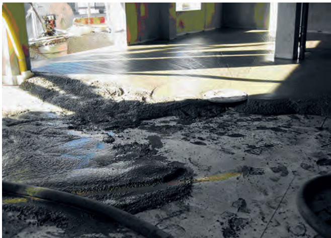
Kuva 5. Kuitubetonilattia
