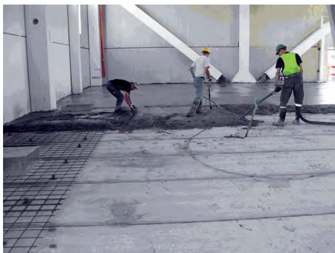
Kuva 19. Betonin levitys, tiivistys ja tasaus
