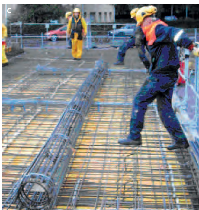
Kuva 18 a, b ja c. Erilaisia välipohjalaatan raudoitteita, irtotango, verkkorautoitteet ja mattorautoite.
