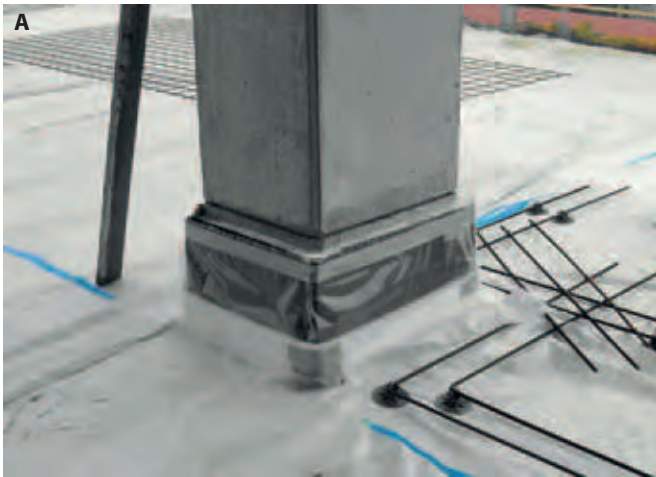
Kuva 23 a ja b. Pilarin irrotuskaista ja lisäraudoitteet
