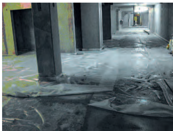
Kuva 27. Pinnan suojaus ja jälkihoito muovikalvolla
