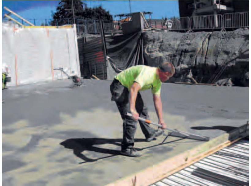
Kuva 25. Kuivasirotteen levitystä
