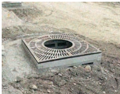
5. Asennetaan kansisto.
