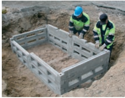
2. Reikäelementtien päälle asennetaan lovetut umpi- ja yläelementit.
