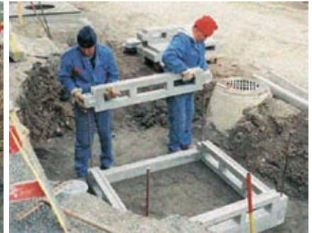
3. Asennetaan alaelementit ja reikäelementit paikoilleen.
