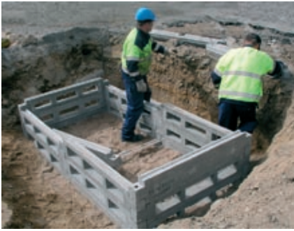
1. Laatikon alimmat kerrokset tehdään samoin kuin KAPU Maxi 1500x2900x960. Reikäelementtejä asennetaan vain kaksi kerrosta päällekkäin. Toiseen päätyyn asennetaan umpielementti.
