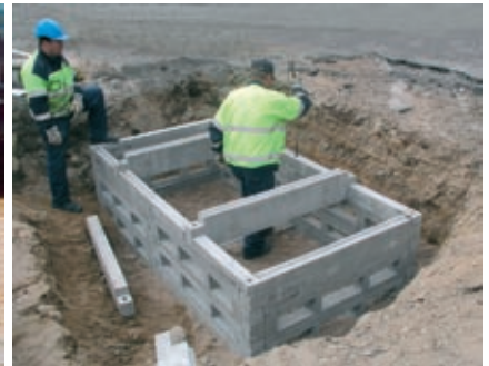
5. Keskimäisen liitoksen terästapit lyödään pohjaan asti.
