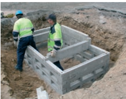
6. Korotusosan sivuille asennetaan ponttaamattomat umpielementit (päältä ta-saiset).
