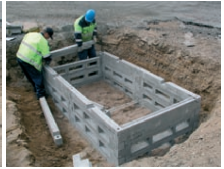
3. Toiseen päätyyn asennetaan yläelementti. Toiseen tulee pontattu umpielementti.
