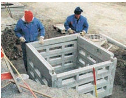
4. Asennetaan umpielementit ja yläelementit.
