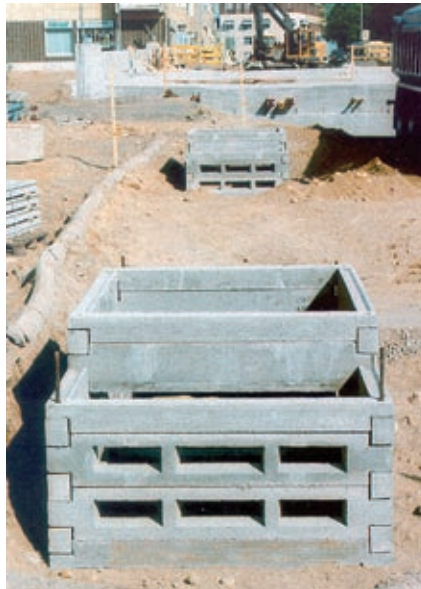
5. Keskimäisen liitoksen terästapit lyödään pohjaan asti.
