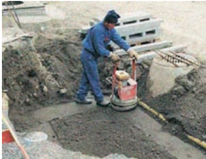
1. Laatikon pohja mitataan oikeaan korkeuteen, tasataan ja tiivistetään.
