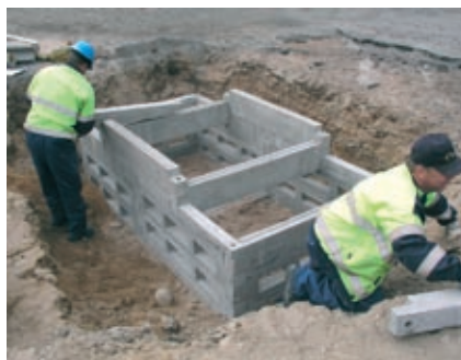
7. Viimeiset yläelementit asennetaan paikalleen.
