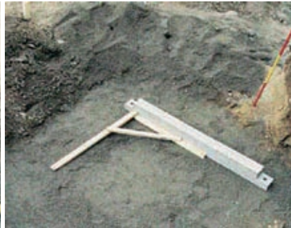
2. Laatikko mitataan paikalleen ja asennus aloitetaan asentamalla toinen alaelementti paikoilleen. Laatikko mitataan suoraan kulmaan.
