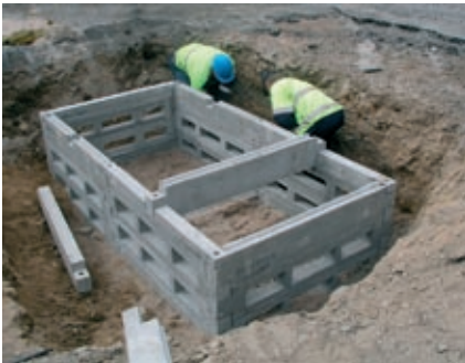
4. Lovettuihin elementteihin asennetaan pontatut umpielementit.
