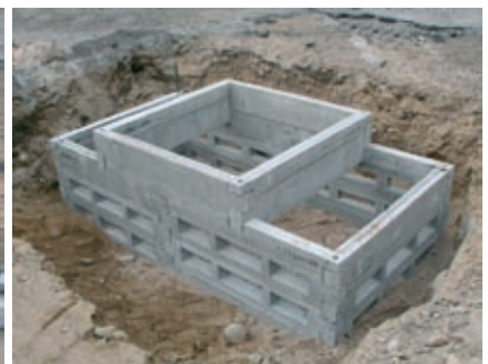
8. Välikannet ja korotusosan kansisto asennetaan yleensä multatäytön jälkeen.
