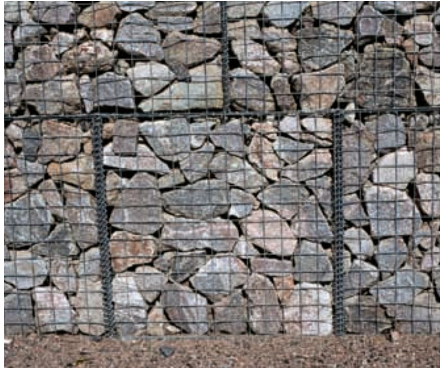
Kivikorimuurin julkisivu on ladottu käsin vaihtelevan värisistä lohkokivistä.
