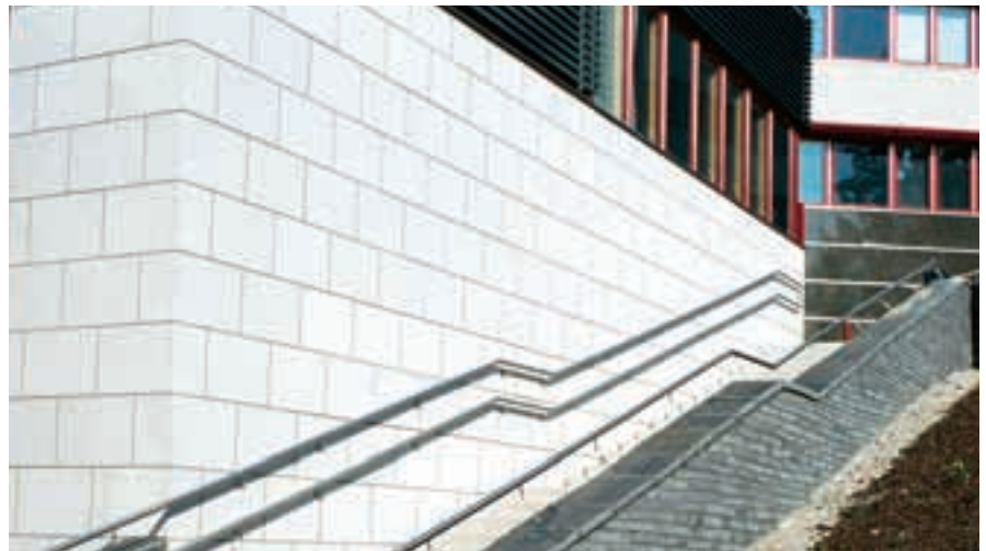
Sokkeliverho on toteutettu polttopintaisilla Kurun harmailta graniittilaatoilla.
