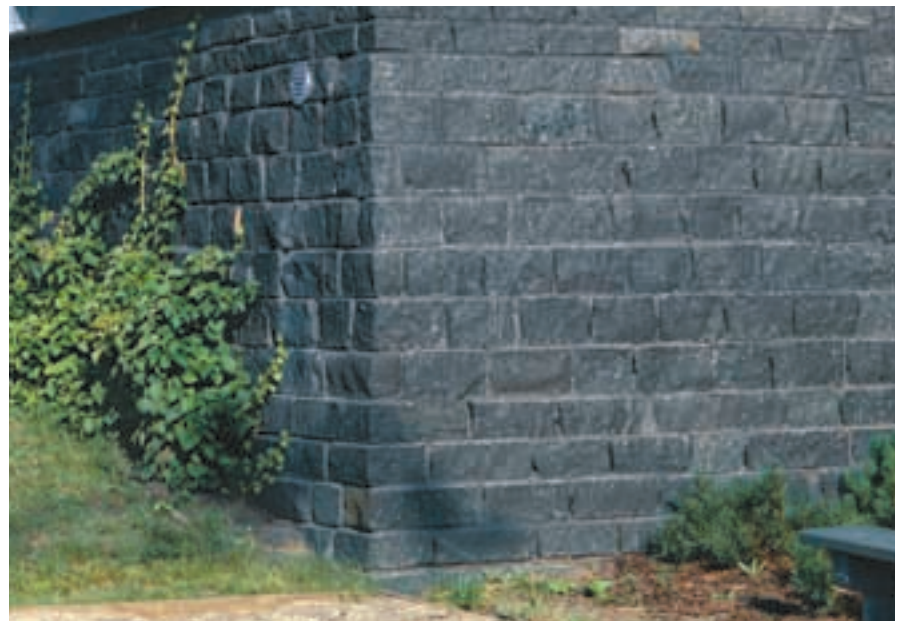
Graniittinen kiverhous on muurattu mustista lohkokivistä ja saumattu mustaksi sävytetyllä saumauslaastilla.
