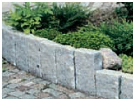
Raakareunakivi on asennettu pystyyn aitakiven tapaan reunukseksi.
