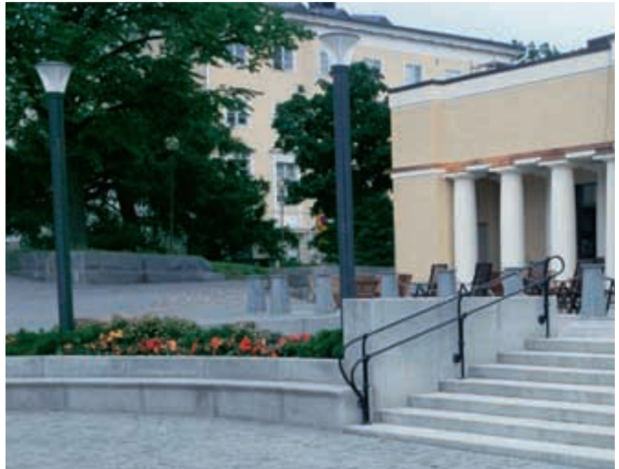
Tampereen keskustorin erikoismuotoiltu paasikivimuuri on ristipähakattua Kurun harmaata graniittia.
