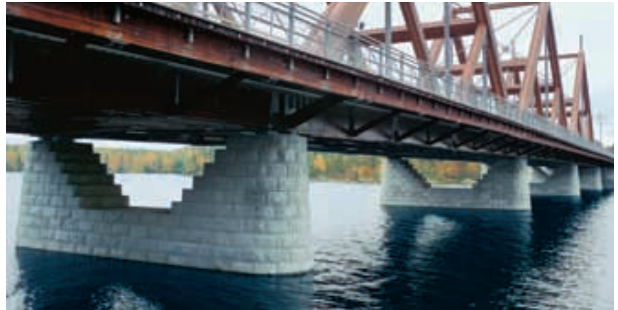
Graniittinen harkkokivi soveltuu hyvän kulutuskestävyytensä vuoksi myös virtapilareiden verhoukseen. Vihantasalmen silta, Mäntyharju.
