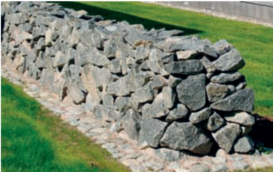
Luonnonmukaiseen lohkarekivimuuriin jätetään avosaumat.
