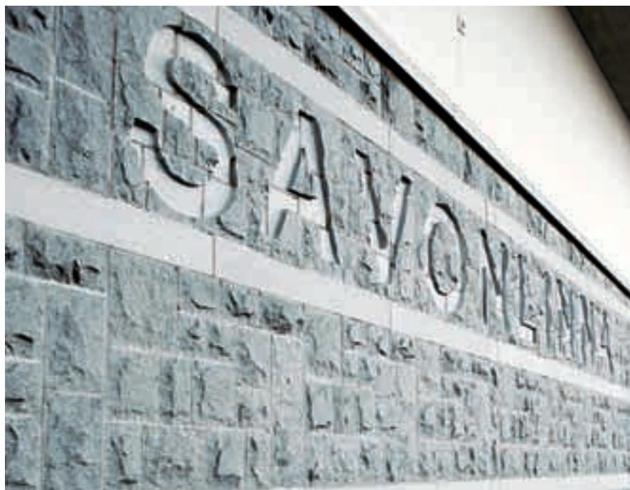
Roomalainen kiviverhous on toteutettu muuraamalla Kurun harmaasta graniitista. Kyrönsalmen silta, Savonlinna.
