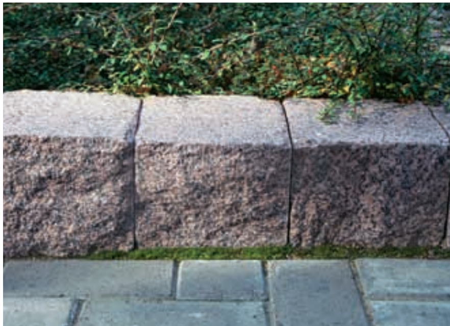
Kuvassa on sahattu punainen kuutiokivi, jonka yläpinta on poltettu ja etupinta lohkottu.
