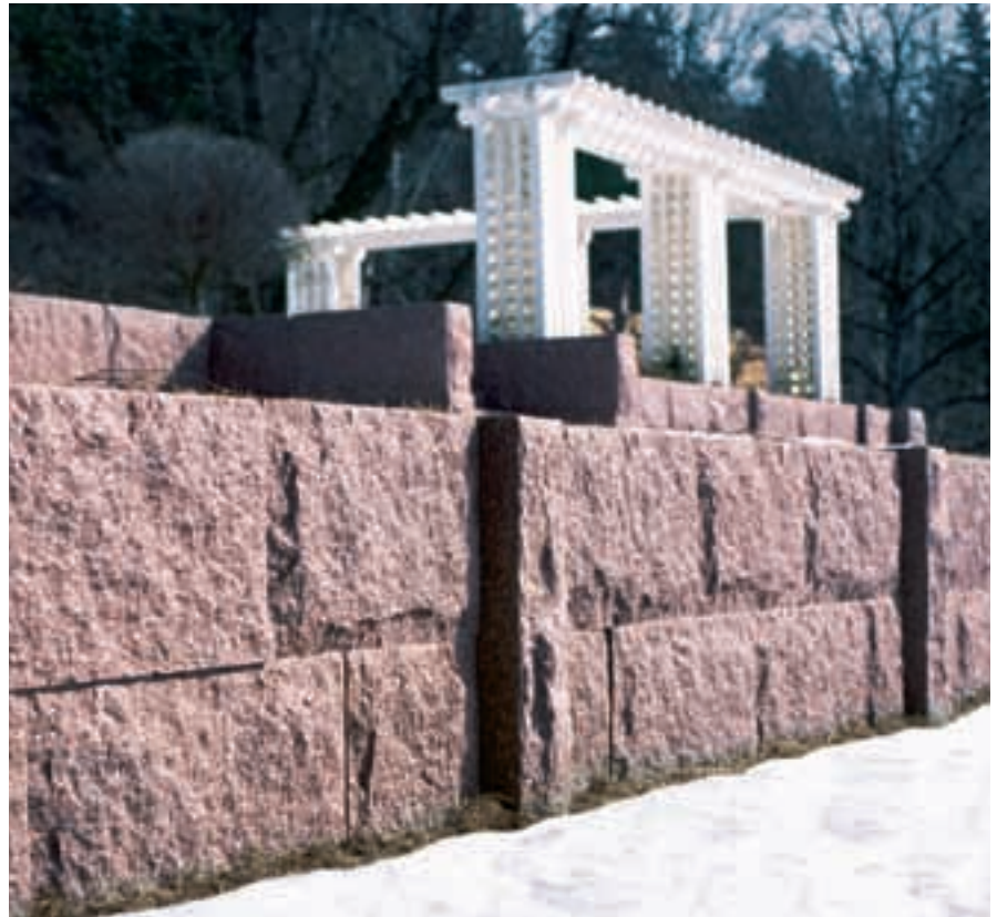
Taivassalon punaiseen lohkopintaiseen harkkomuuriin on saatu lisää ilmettä pystymallisilla aitakivillä.
