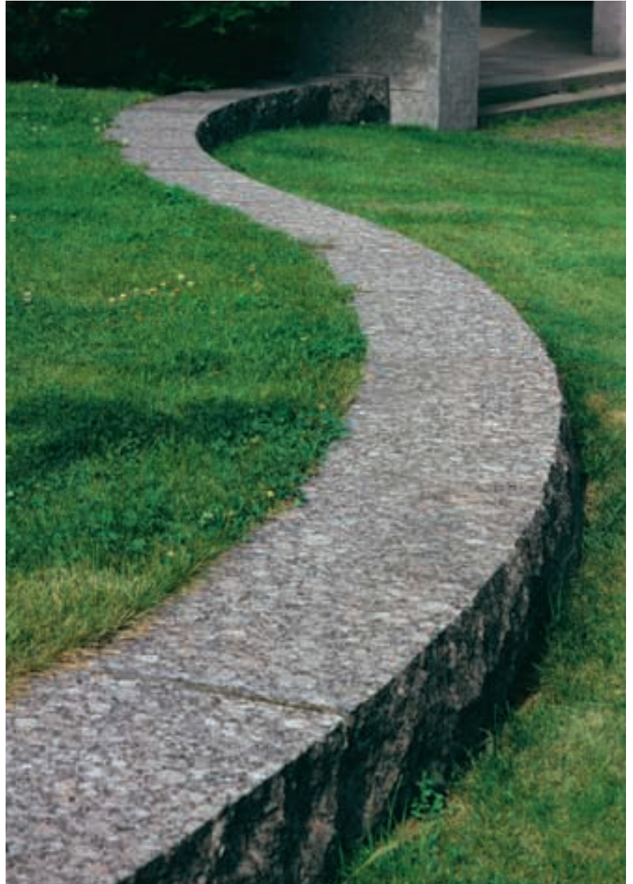
Kansallisoopperan paasikivimuuri Helsingissä on julkisivupinnaltaan lohkottua ja yläpinnaltaan poltettua Ylämaan ruskeaa graniittia.
