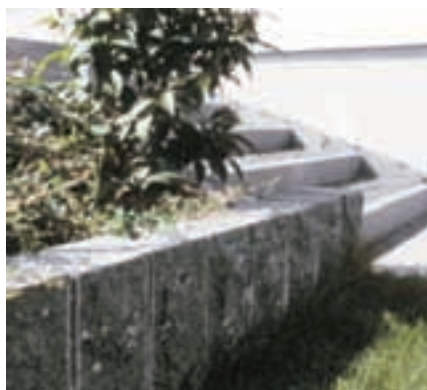
Muurin julkisivu on lohkopintaista Korpilahden mustaa graniittia ja aitakivien yläpinta on poltettu.
