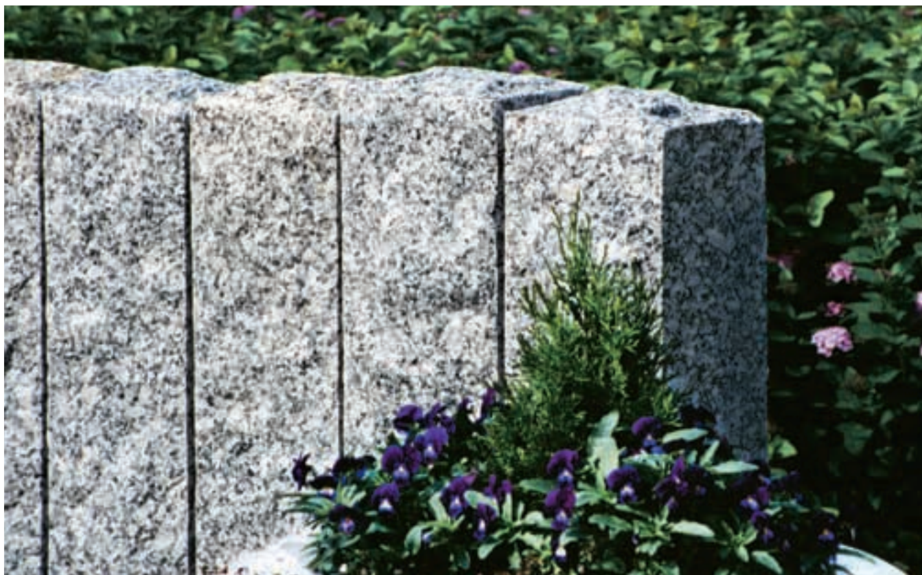
Viitasaaren vaaleanharmaasta graniitista valmistettujen aitakivien yläpinnat ovat lohkopintaisia ja muurin yläpinnan taso haluttu jättää vaihtelevaksi.
