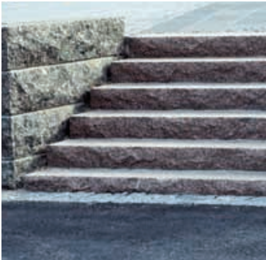
Taivassalon punaisten portaiden yhteydessä on käytetty Ylämaan ruskeaa harkkomuuria. Askelmien etupinta on lohkottu.
