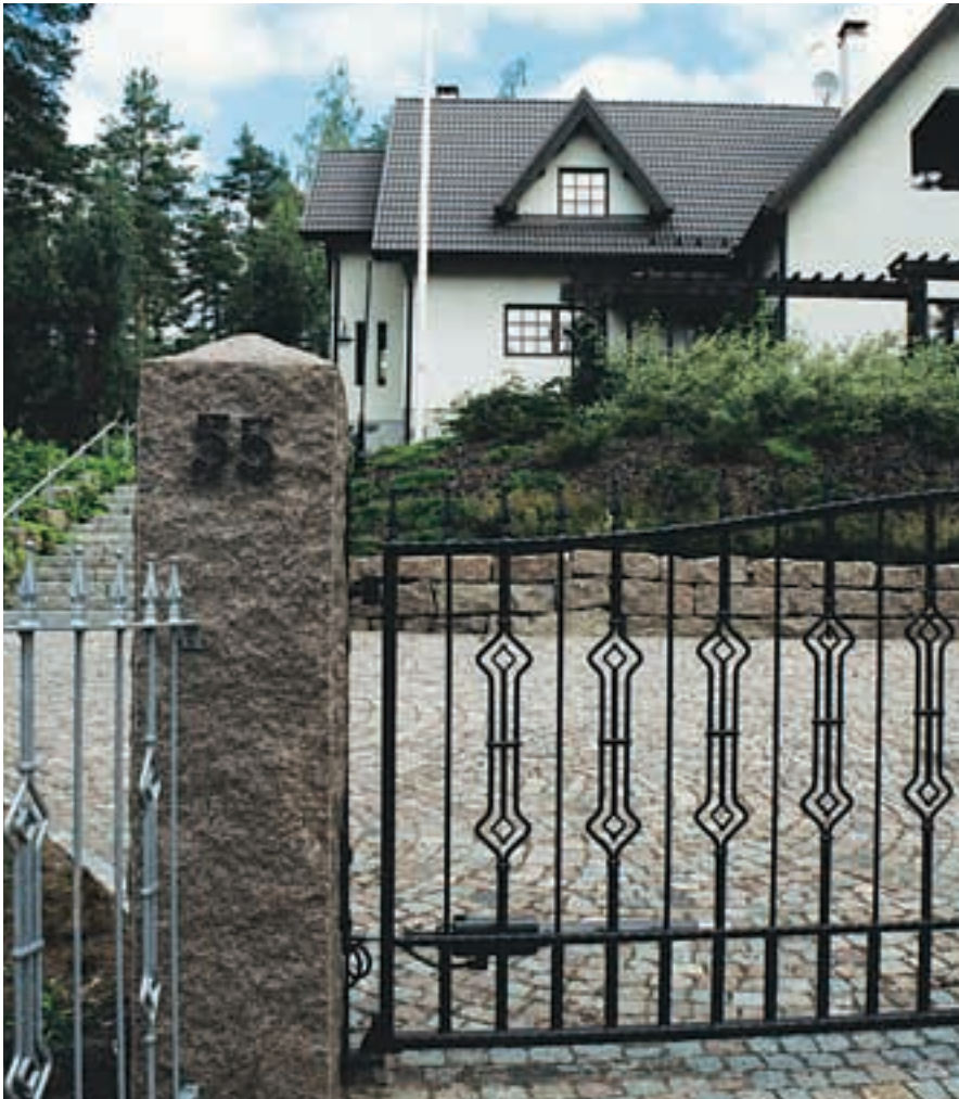
Lohkottu Taivassalon punainen suorakaidepollari toimii myös portin pylväänä. Pollariin on erikoistilauksesta työstetty kartiomainen pää ja reiät portin kiinnikkeille.
