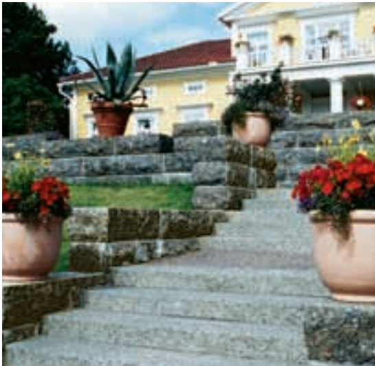
Kuvan Ylämaan ruskeat portaat on tuettu reunoiltaan harkkokiivillä.
