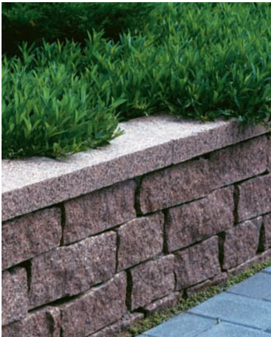
Taivassalon punainen lohkokivimuuri on asennettu avosaumoin.
