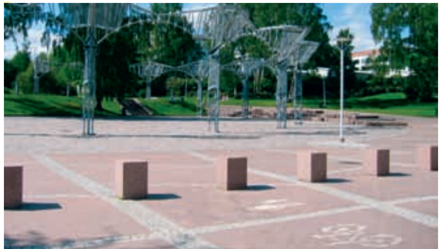
Toripinnan rajaus pyörä- ja jalankulku tiestä on toteutettu punaisilla, poltettupintaisilla suorakaidepollareilla.
